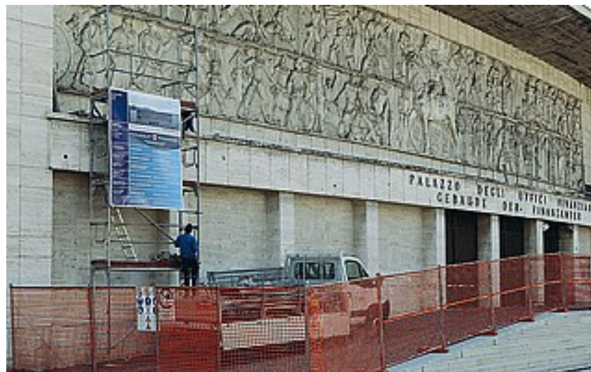
Ponteggi | I lavori di depotenziamento del rilievo iniziati ieri (foto Klotz-Rensi)
